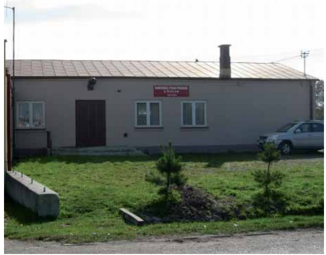
Fot. Budynek świetlicy wiejskiej w Mokrem. Przed realizacją projektu
