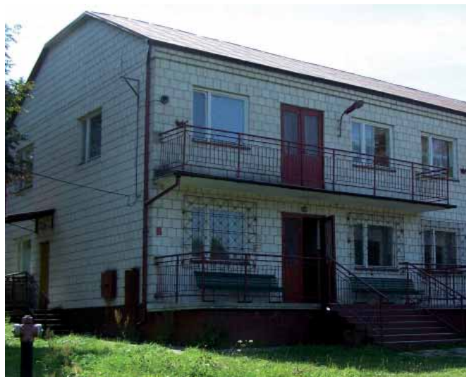
Fot. Remiza OSP w Potoczku – przed realizacją projektu
