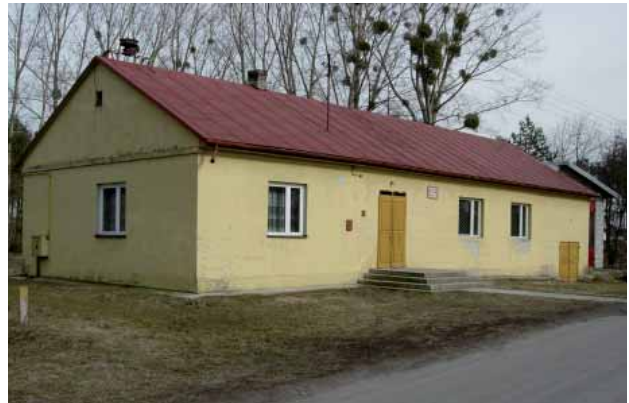
Fot. Świetlica wiejska w Pniówku – przed realizacją projektu
